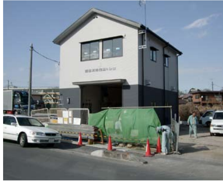
加治東側で建設中の第6分団新詰所
